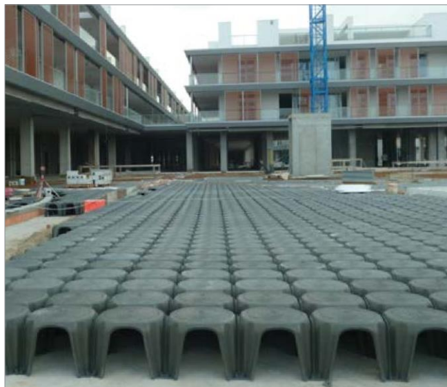
Realizzazione di un piazzale per un complesso residenziale
