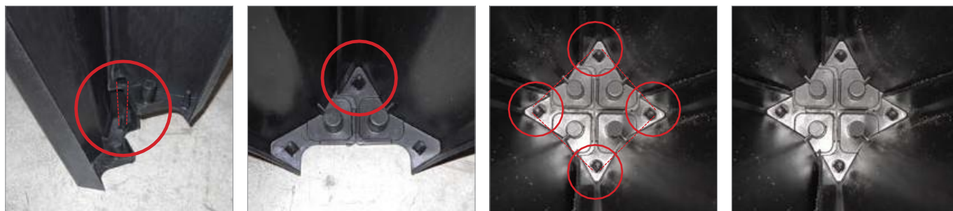
Fig. 3 - Detaliu al fazei de imbinare a sistemului tata/mama - Observați etanșarea perfectă a piciorului.
