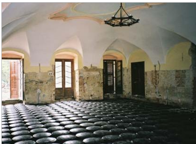
Ristrutturazione di una villa
