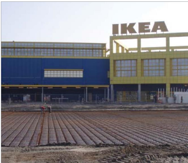
Vasca di dispersione al di sotto di un parcheggio commerciale
