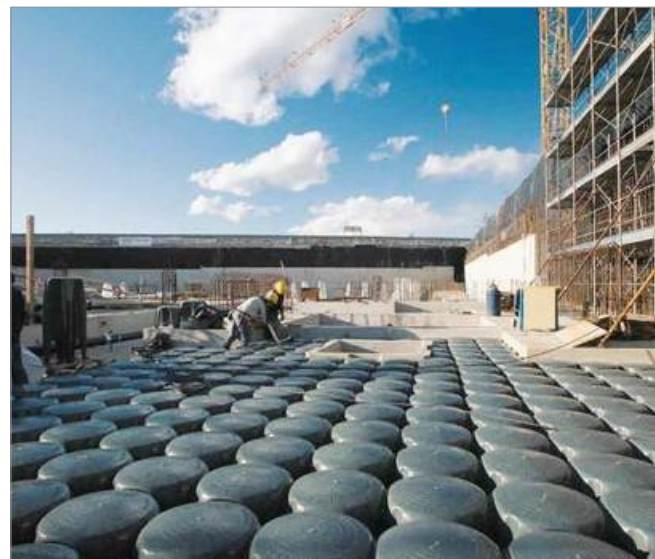
ITC Lab - Edificio a uso commerciale
