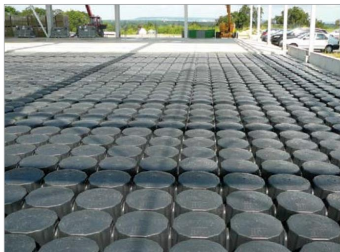
Intercapedine ventilata per edificio ad uso industriale
