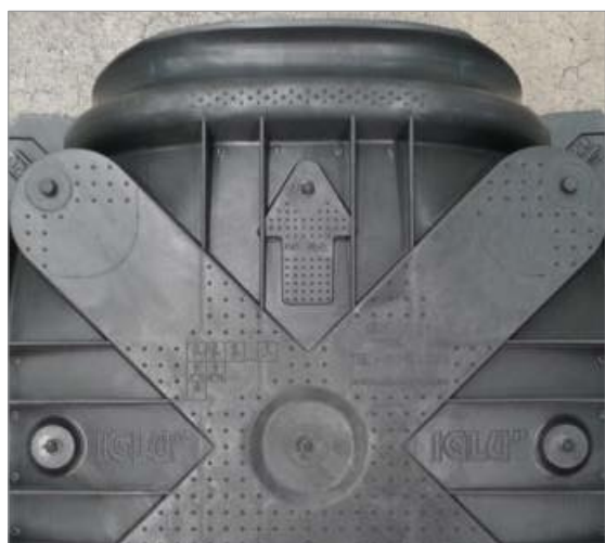
Fig. 1 - Așezarea primului cofraj, săgeata spre bordura fundației.
